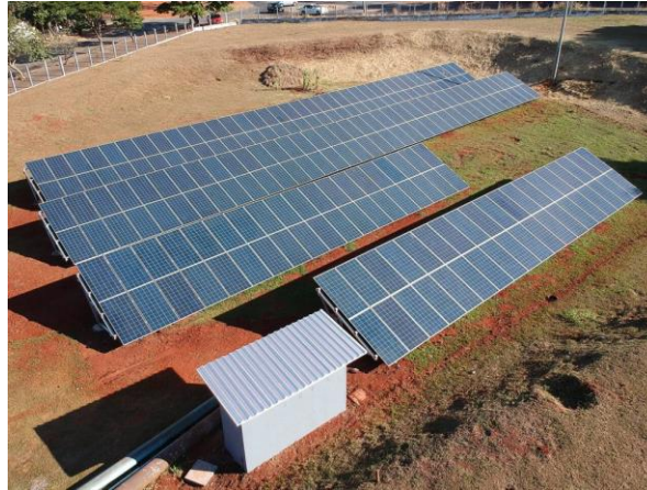
Figura 12: Casa de máquinas na usina solar (imagem ilustrativa)
